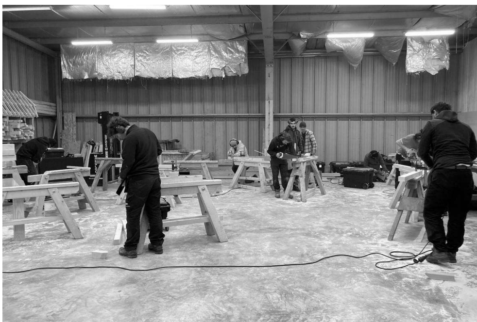
Image 1 : l'atelier de fabrication en charpente
